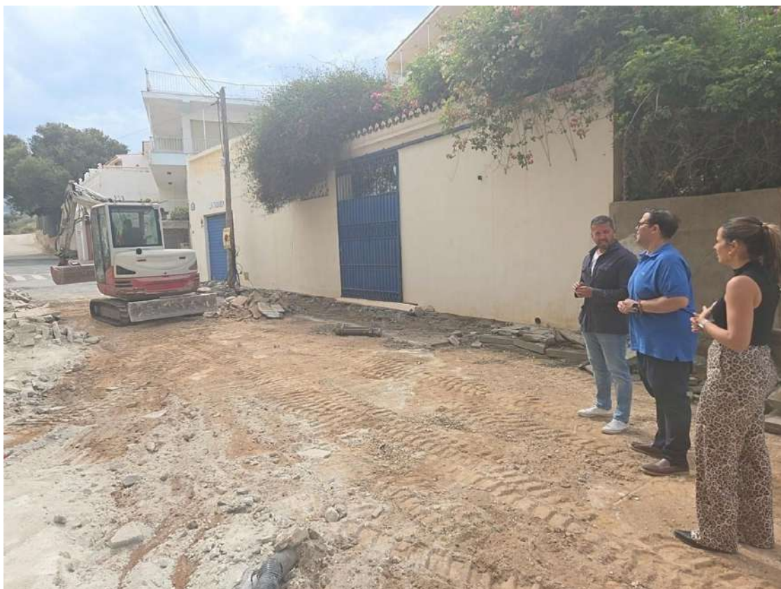
Visita al inicio de las obras en Torrenueva Costa
