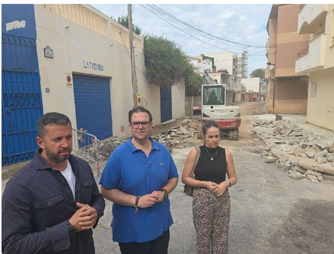
Visita de las autoridades a las obras en calle Peñón de Jolúcar (EL FARO)
