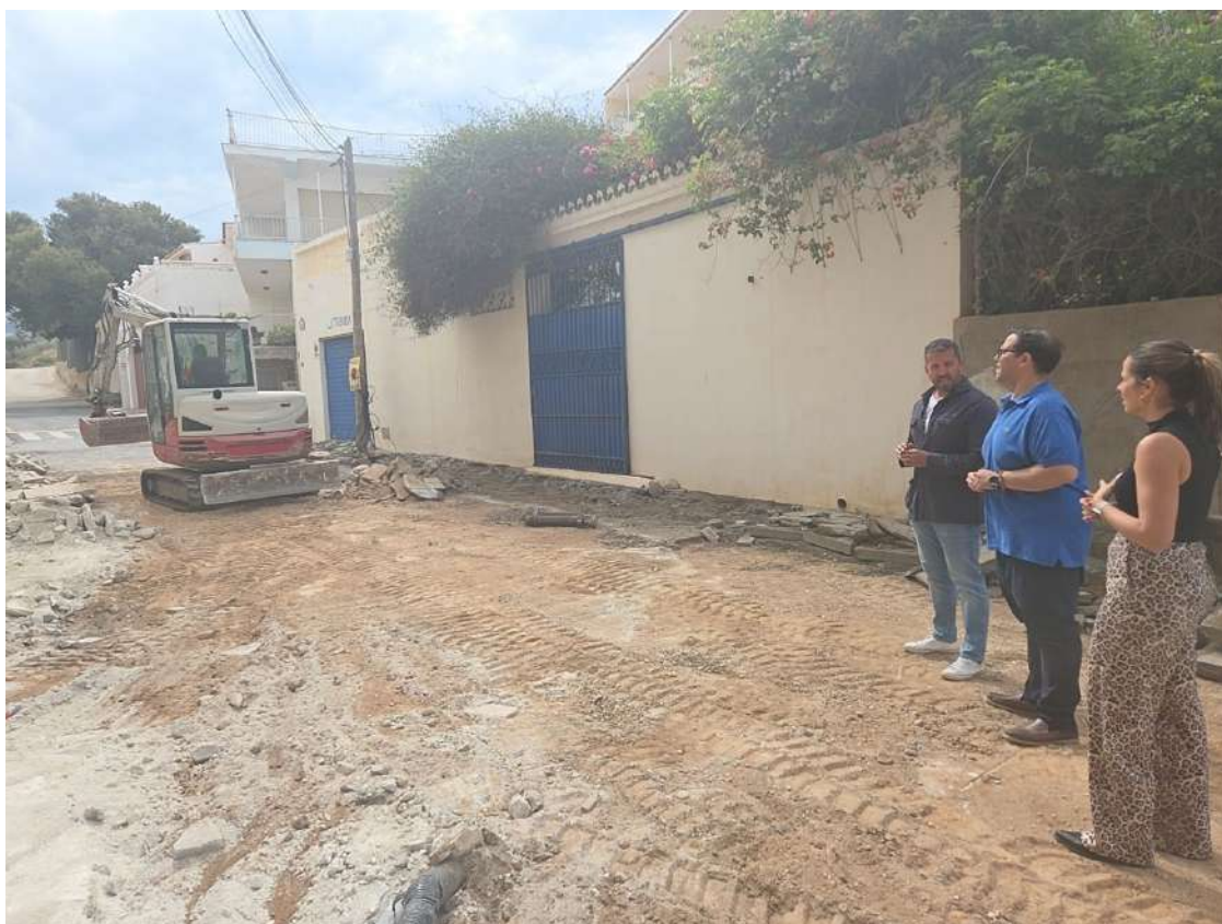
Visita de las autoridades a las obras en calle Peñón de Jolúcar (EL FARO)
